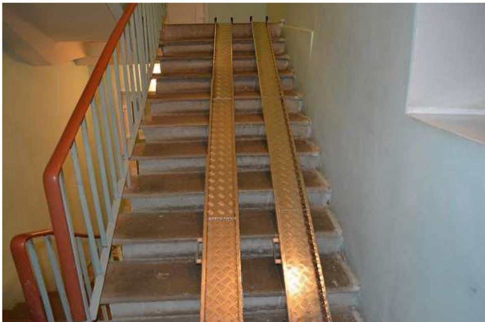
Пандус-платформа обеспечивает возможность подъема людей на инвалидных колясках в тех местах, где нет стационарных пандусов и лестничных подъемников.
